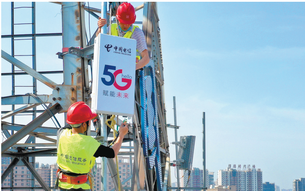
Сотрудники отдела компании China Telecom в городе Луань провинции Аньхой монтируют и проводят испытание одной из базовых станций 5G.
