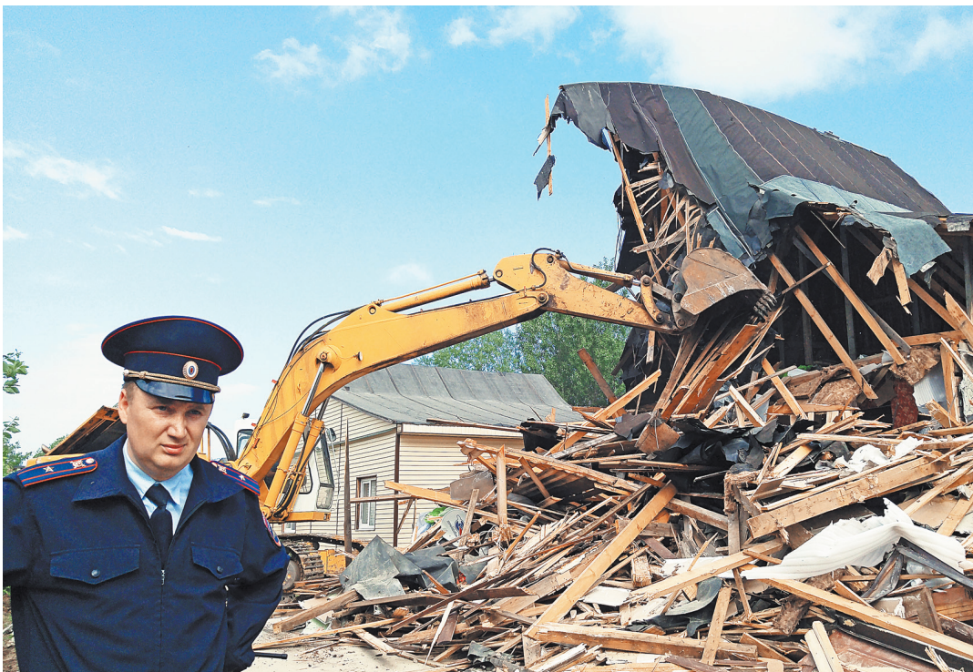
К полудню было демонтировано десять незаконных построек, запланированных к сносу.
