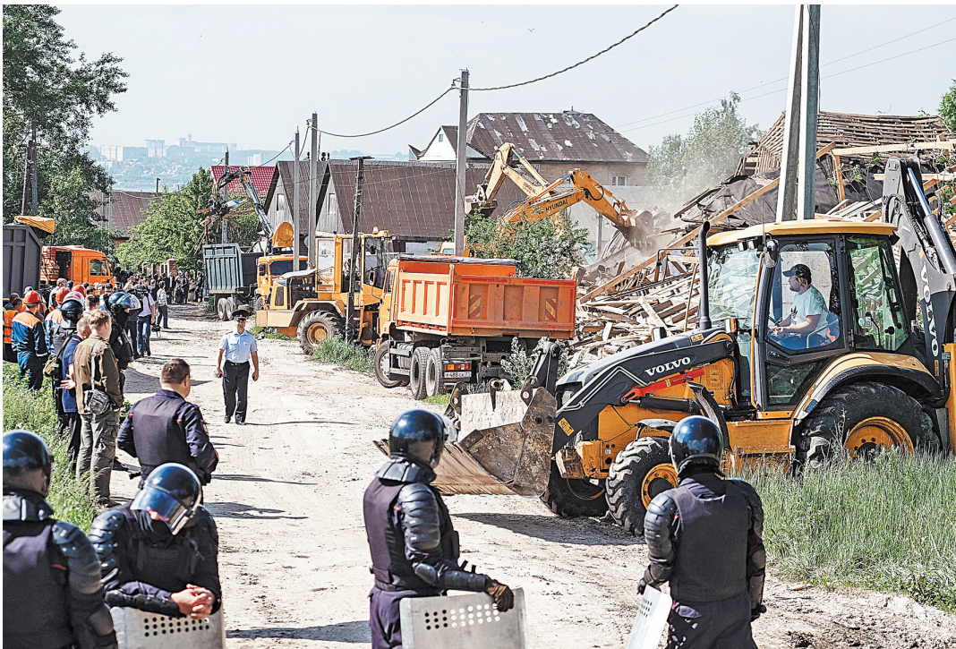
Рано утром в Плеханово прибыло с десяток бульдозеров, экскаваторов и самосвалов. Жители были заранее предупреждены о начале работ.
