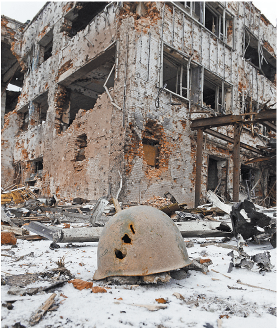
В ходе боев аэропорт Донецка был полностью разрушен.
