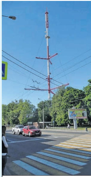
На мачте пройдут монтажные работы.
